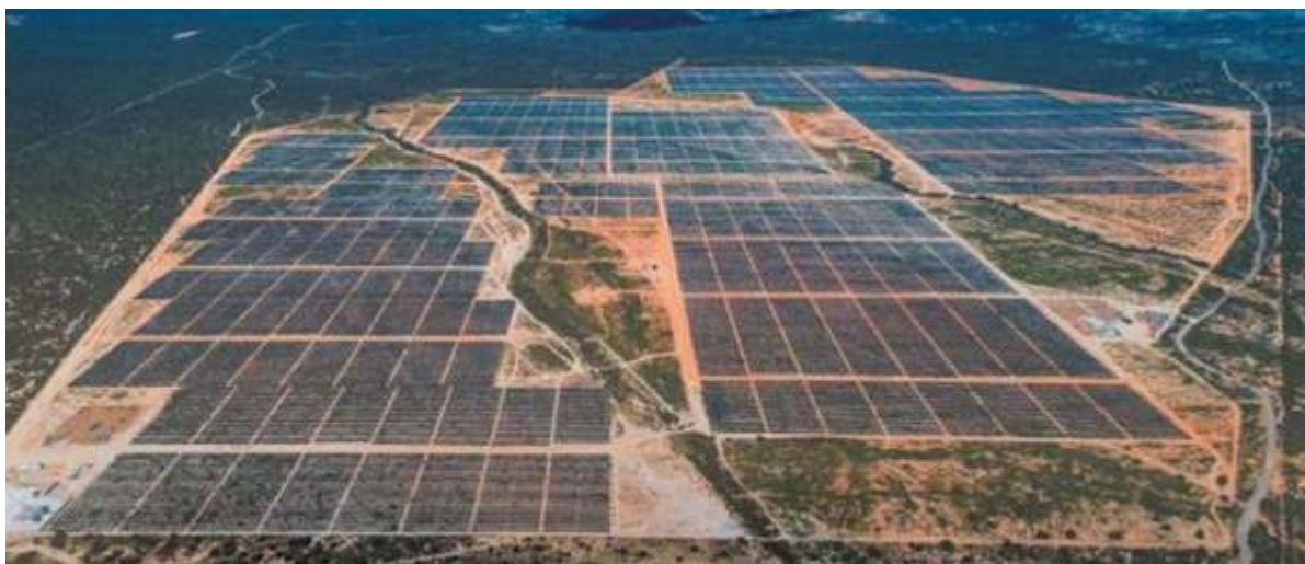
Figura 19: Foto del parque fotovoltaico Núñez de Balboa, en Usagre (Badajoz), propiedad de Iberdrola. Fuente: Junta de Extremadura.
